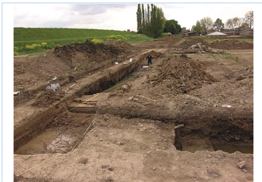
Opgravingen van de funderingen van een 13 e eeuwse toren van Het huys Varick
